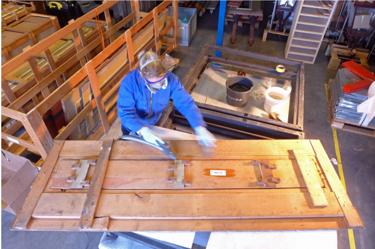
Afb. 14 Stagiaire Jettie Timmer tijdens het schoonmaken van een paneel met schuifklampen.
