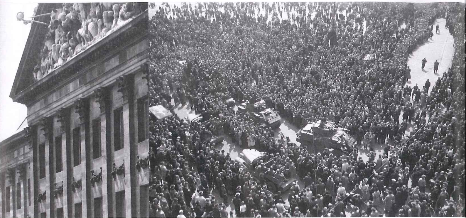
Vlnr: Duitsers kijken naar Britse verkenkers op de Dam; Duitse soldaten op het dak van de Grote Club; de Britse verkenkers en de Duitsers op de Dam
