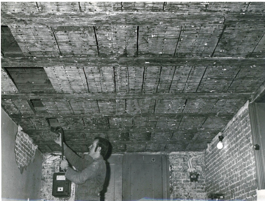
Afb. 15 De eerste sloop van het plafond in 1969
