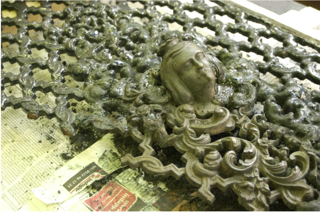
Afb. 7 Gietijzeren deurraam – de ramen waren dichtgeslibd door vele lagen verf, één van de ramen was bovendien gebroken
