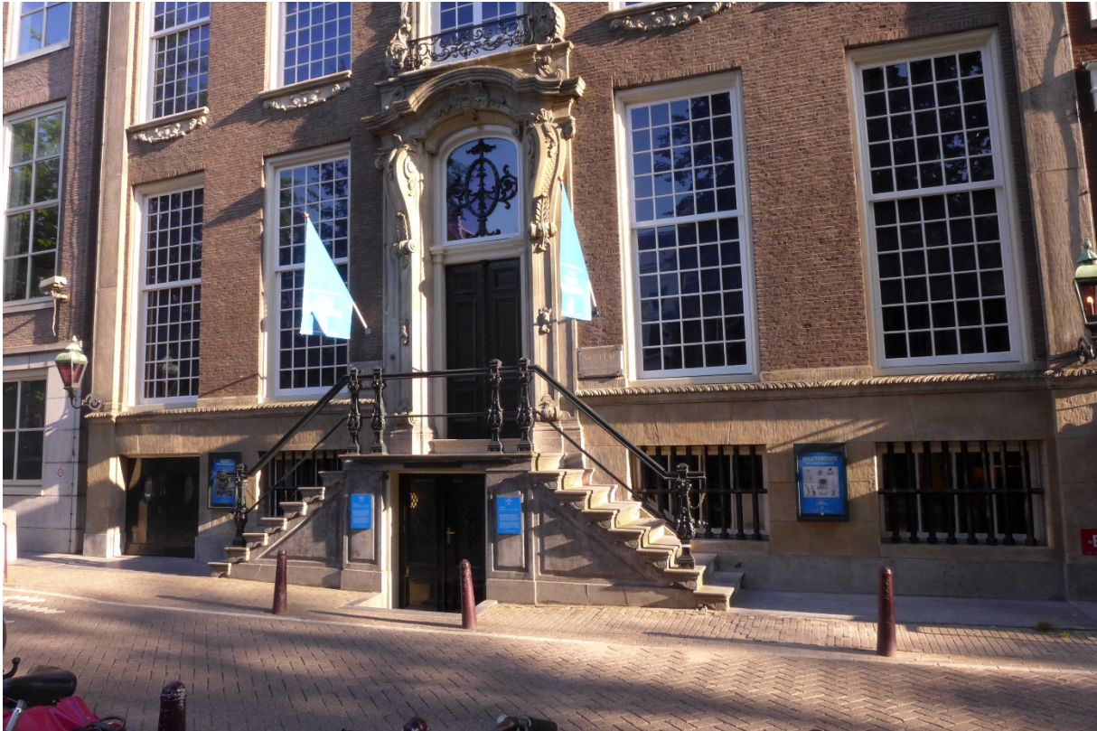
Afb. 1 Voorgevel souterrain deel
