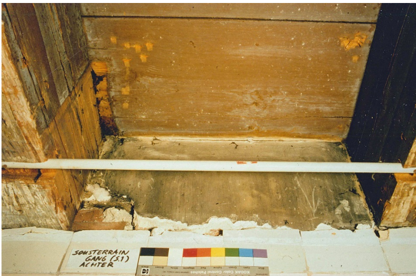
Afb. 18 In het achterste deel van de gang was slechts oude witkalk en stuc boven het moderne plafond
