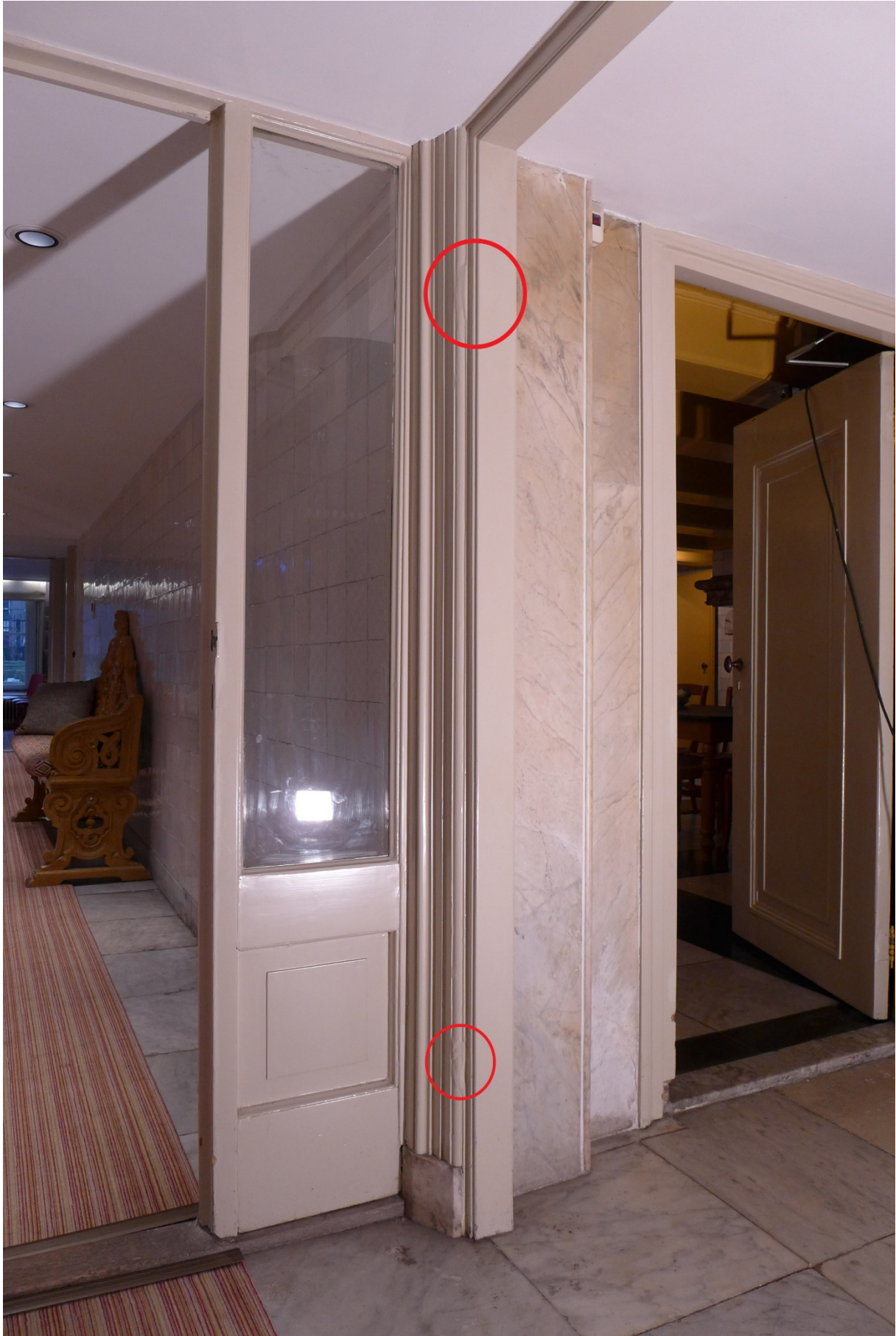
Afb. 13 Detail met overschilderde scharnierrestanten in het kozijn omcirkeld
