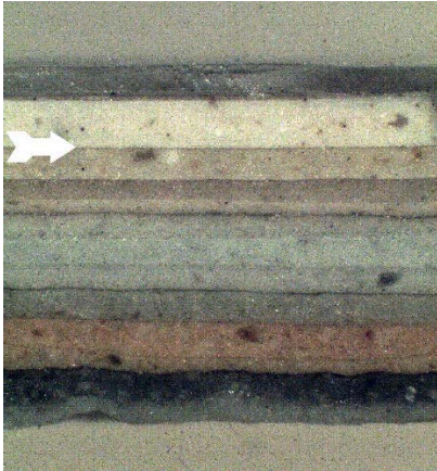
Afb. 27 Een verfmonster van het raamkozijn laat zien hoe pas vrij recent het houtwerk wit geschilderd werd (lagen boven de pijl). Uit andere monsters blijkt dat dit plaatsvond na verwijdering van de tralies.
