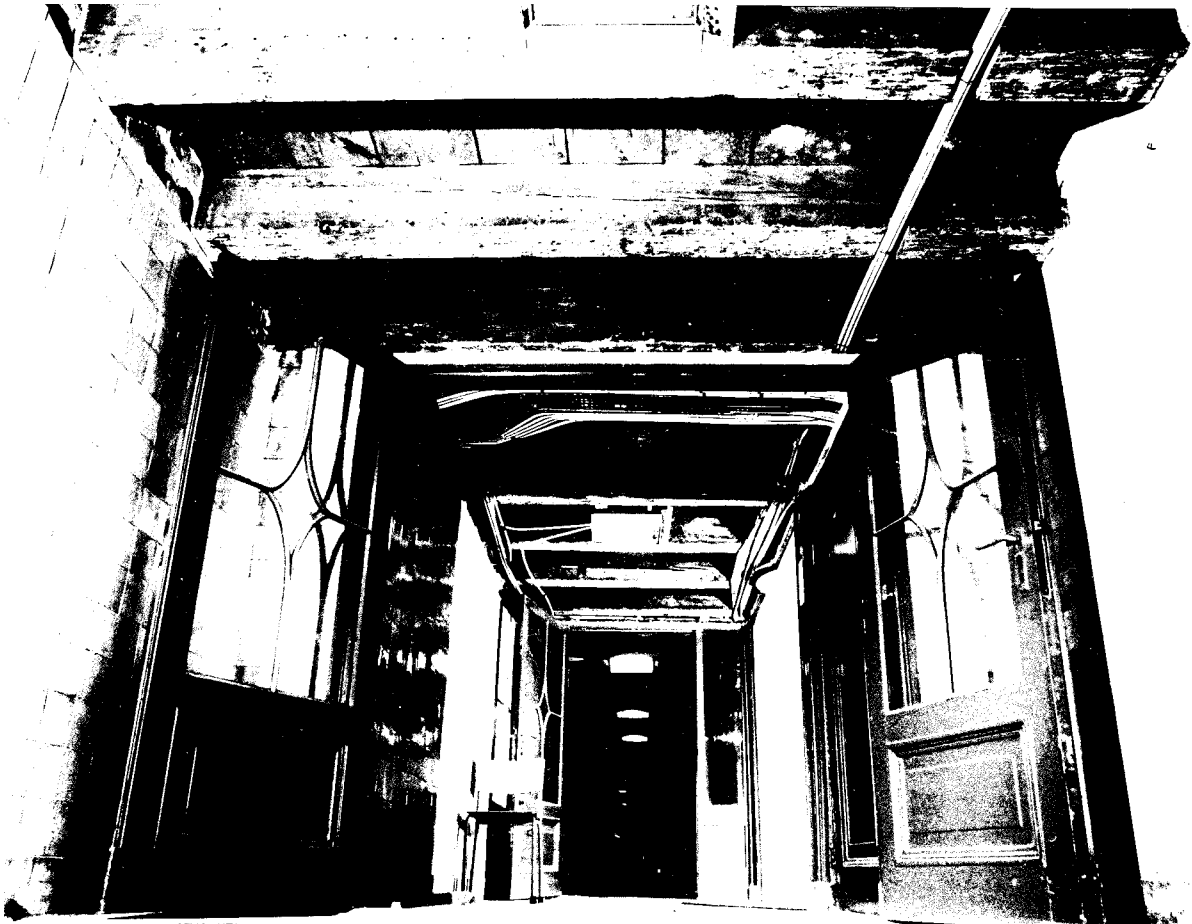
Afb. 16 De bekabeling en plafondverlichting uit 1969 opnieuw in het zicht tijdens de renovatie van 1996
